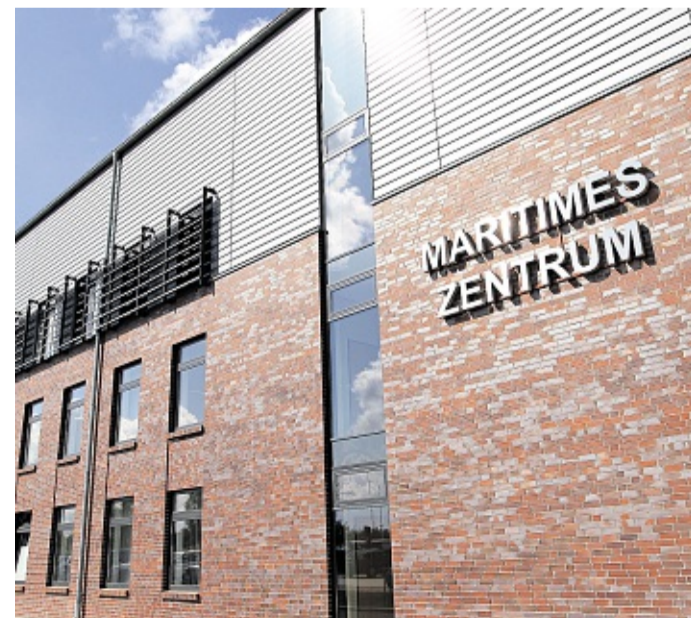
Die Maritimen Technologien gehören zu den zentralen Feldern der Hochschule.
